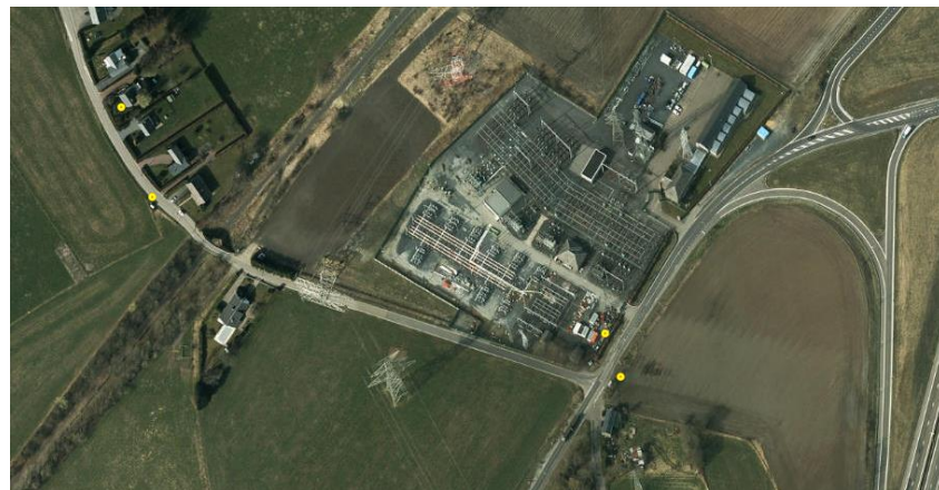
Figure 3 : Vue aérienne des abords de la centrale électrique de Villeroux
