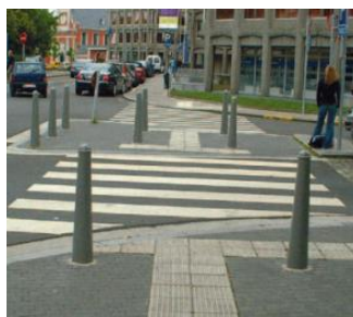
Figure 4. Dalles de guidage vers une traversée piétonne
