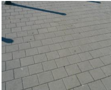
Figure 1. Revêtement modulaire en dalles de béton
