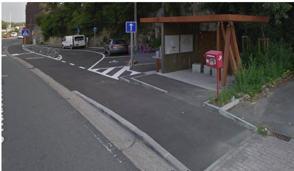
Figure 59 : arrêt de bus mobipôle Argenteau
