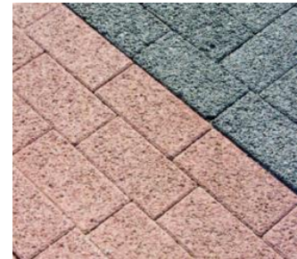
Figure 3. Revêtement drainant en pavés de béton poreux
