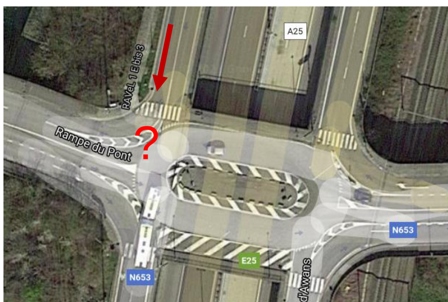
Figure 61 : traversée difficile piétons / vélos échangeur Argenteau
