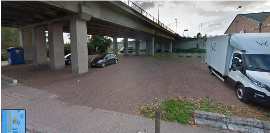
Parking rue Basse sous le pont N653
