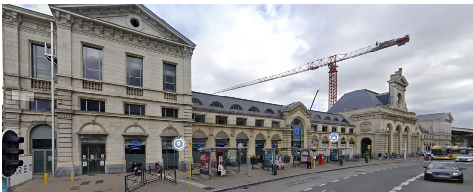
Figure 107 : point ProVélo à la gare de Namur
