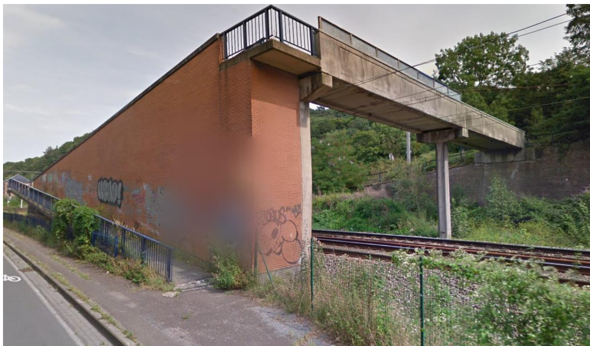
Figure 17 : passerelle à Argenteau
