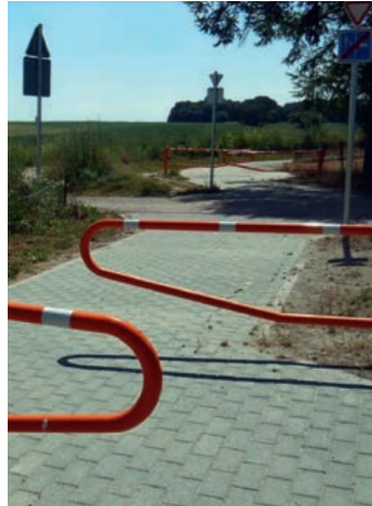
Figure 19. Exemple de chicanes pour changer la trajectoire du piéton et signaler la présence d'un danger (Source : CeMathèque n°39)
