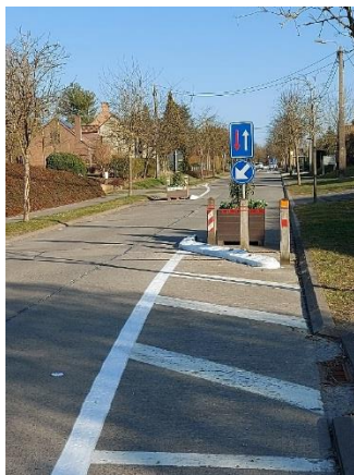
Figure 107: photo des aménagements en chicane – Source : Agora
