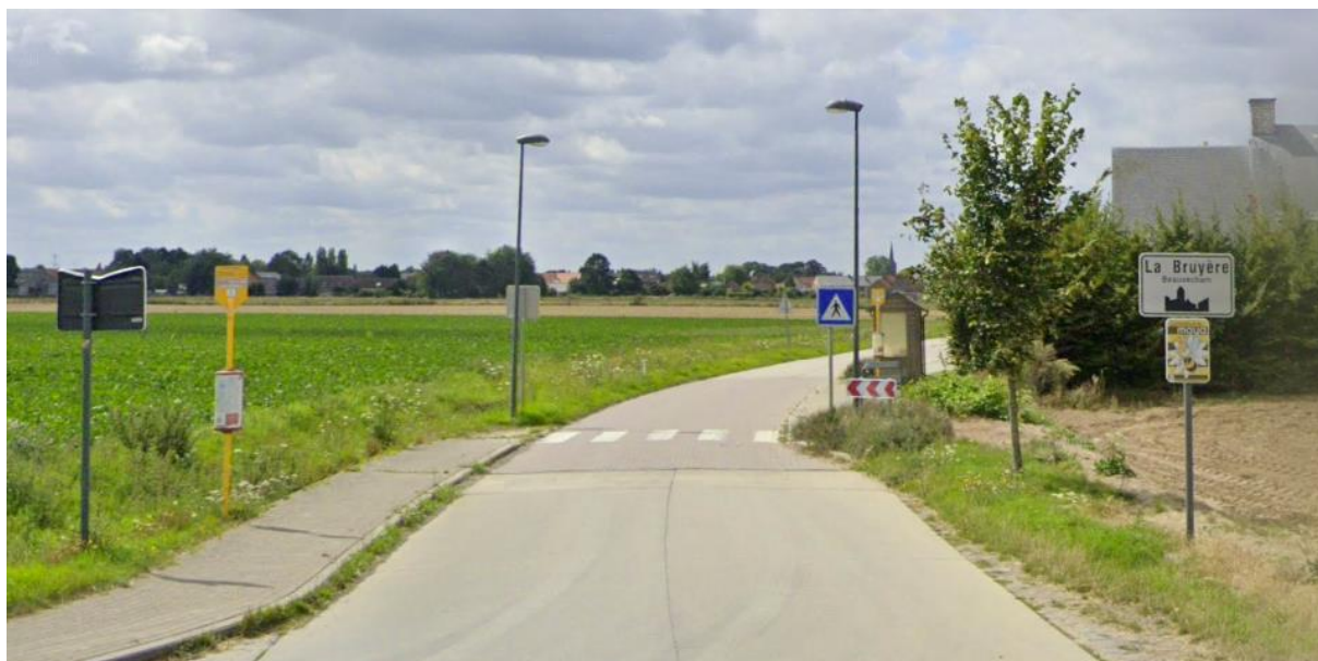
Figure 103: photo de l'entrée de la Bruyère – source : Googlemaps
