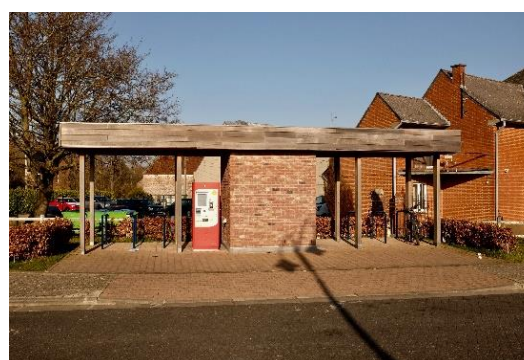
Figure 65: photo de l'entrée Hamme-Mille
