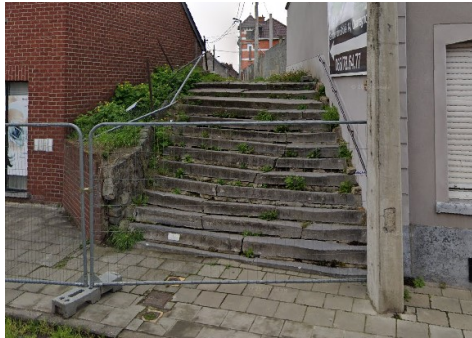
4 rue de la Courbelette, qui est sur l'itinéraire Ville-Gare et proche de la N51 visée par projet de réaménagement
