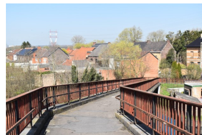
Figure 18: Sentier le long de l'Avenue du Travail
