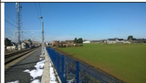
Figure 3 : En amont du tracé
