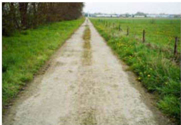
Béton mono-bande (150-200€/mct)
