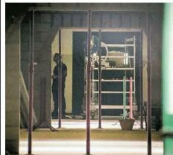
▲ I lavori. Ultimi ritocchi in via Corelli
